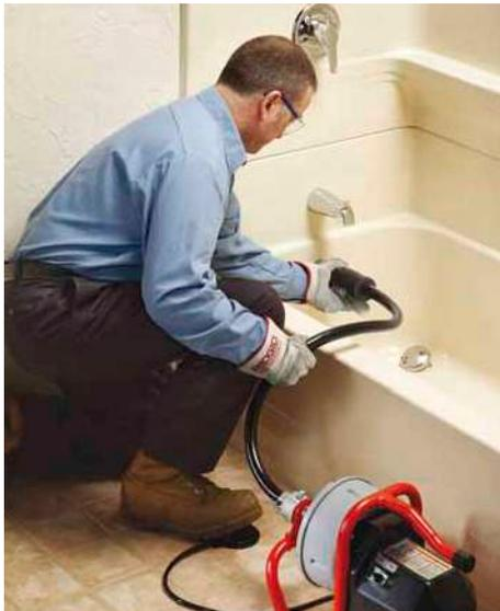
**Dans la salle de bain :** Sa structure compacte facilite l'accès aux zones difficiles telles que les baignoires et les armoires sous les éviers tout en maintenant le flexible à l'écart de toutes les surfaces finies.
